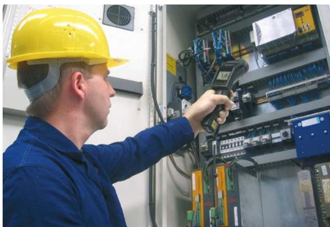
Inspection détaillée d'une armoire électrique avec un optris LS, incluant un spot de 1 mm.
